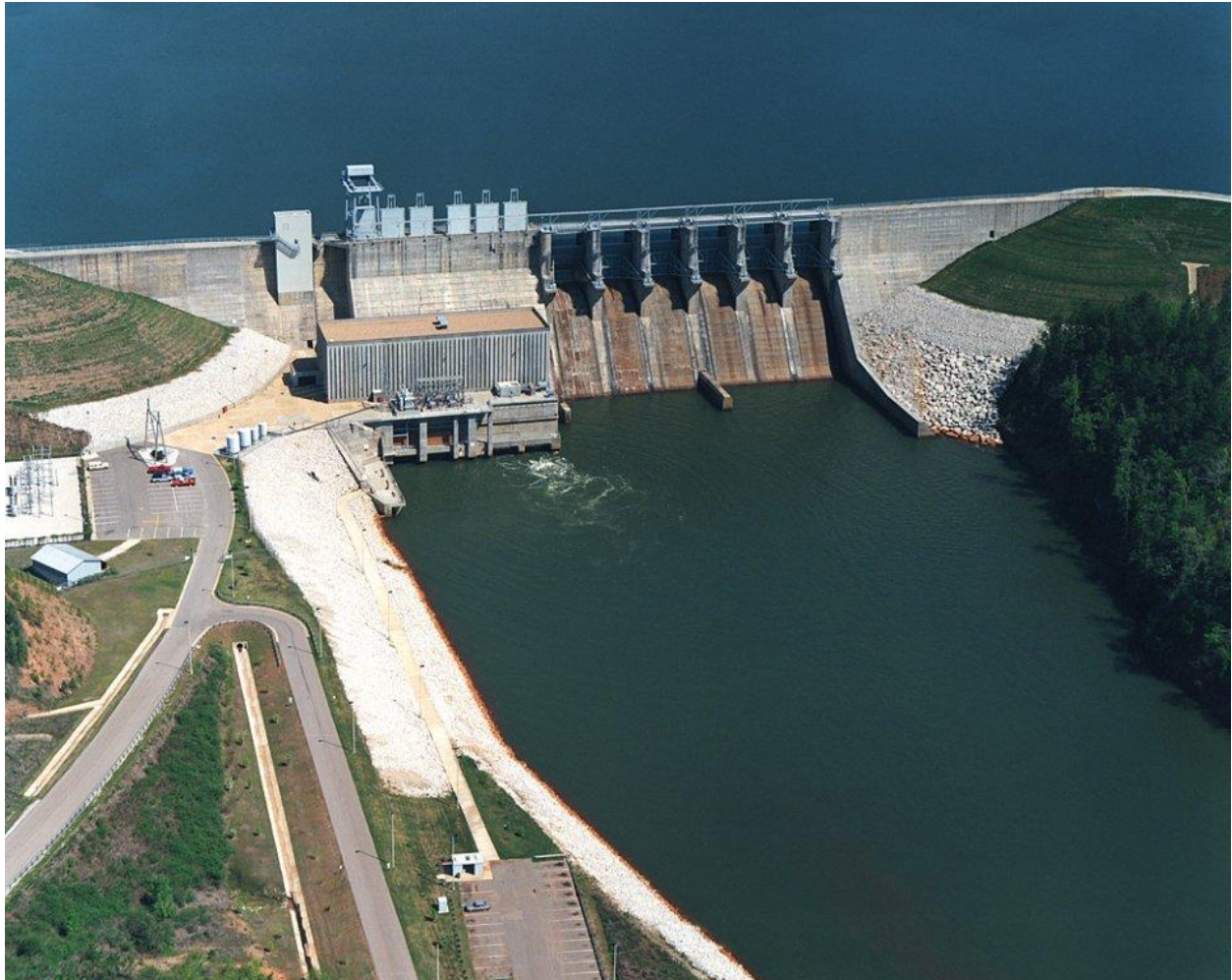
Figure 2-1. R. L. Harris Dam
