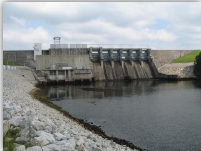
Figure 4-7. R. L. Harris Dam
